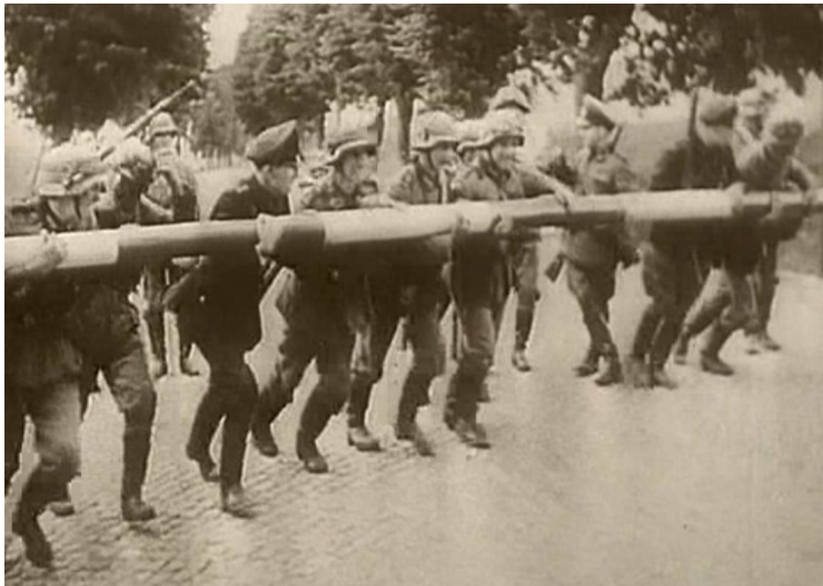
.. die Grenzbalken werden ausgehoben
